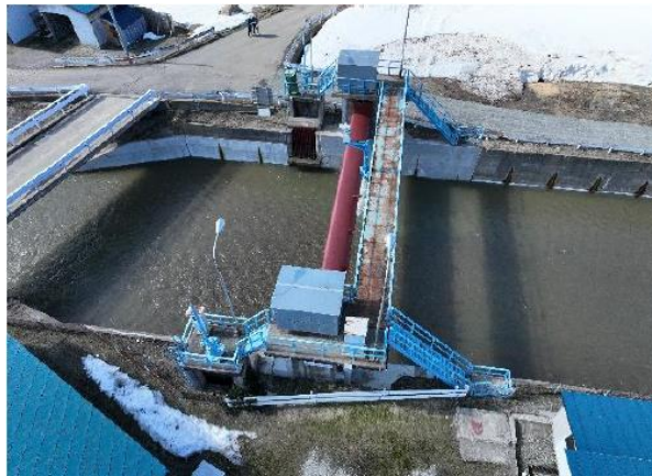
【飯詰第三頭首工 躯体補修工事（左岸）】
