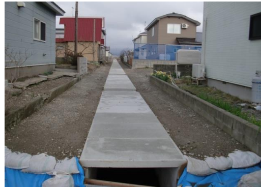
排水路工 L=1,991m
