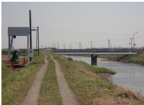
中里南部2号水管橋及び3号水管橋 施設補修一式
