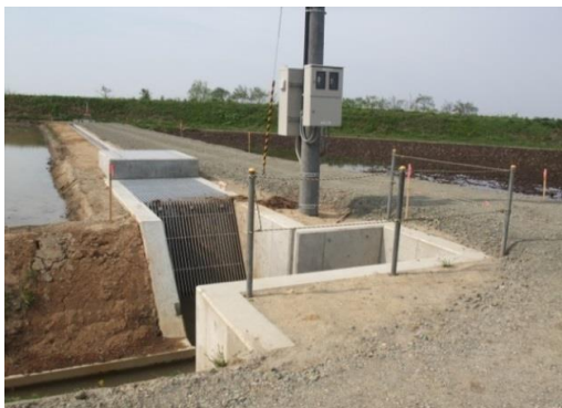
管水路工 L=700m 揚水機場 N=一式
