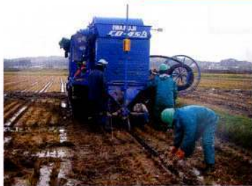
飯詰地区 暗渠排水220ha
